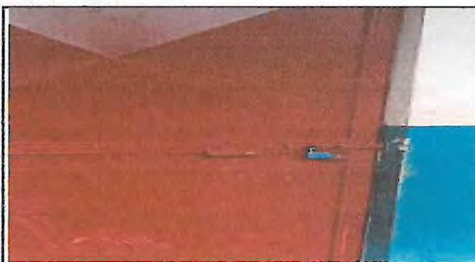
Sustitución de chapas
