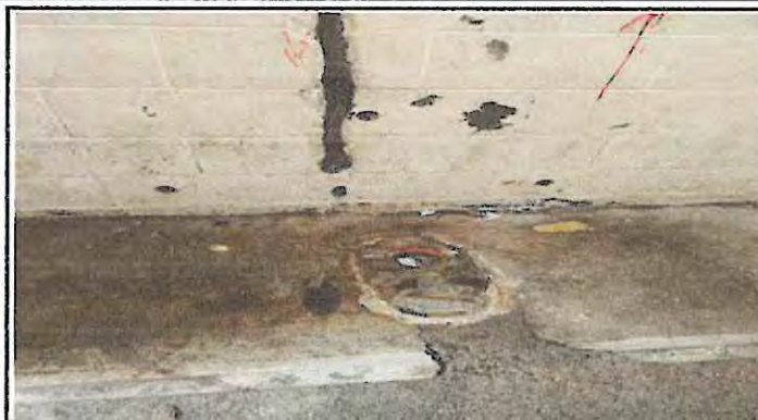
Sustitución de Sanitarios
