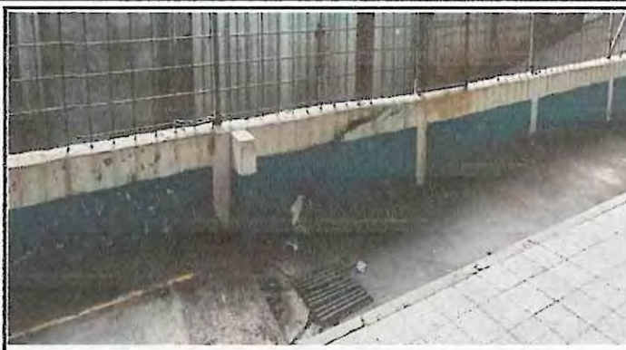
Reparación de muro perimetral y drenaje
