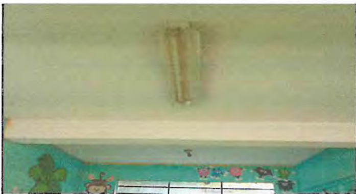
Sustitución de focos.
